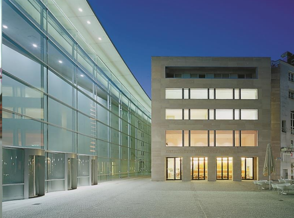
Hauptsitz in Nürnberg, Luitpoldstrasse
