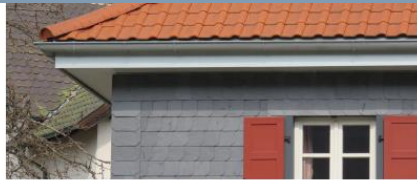
Sanierungsbeispiel in der Angerstraße in Wallenfels
